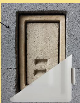
Do otvoru ve vybíracím kusu v prostoru půdy je nutné osadit šamotový uzávěr a komínová dvířka. Rám dvířek přiložit na šamotovou přírubu. NESPOJOVAT! Šamotový kourovod se pohybuje nahoru a dolů v závislosti na teplotě spalin. Druhý vybírací kus se používá pouze v případě, kdy není možné komín čistit ze střechy.
